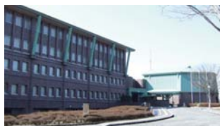
(写真左側が管理研修棟、右側が講堂)
